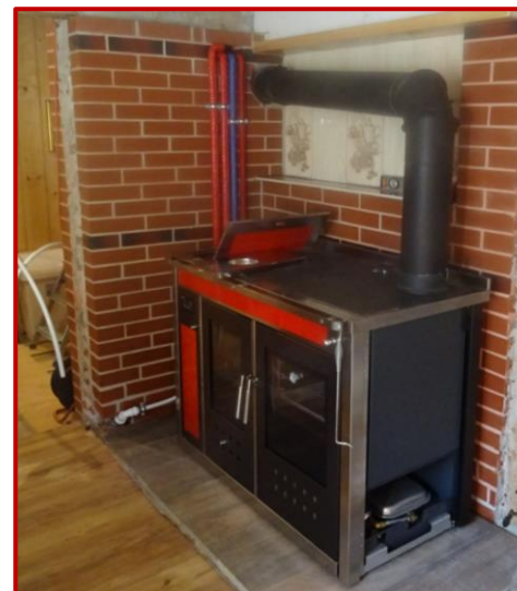
Przykład zastosowania termokuchni przy okazji remontu starego budynku na wsi.
