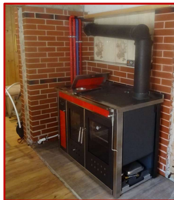
Przykład zabudowy termokuchni w miejscu starego pieca kuchennego na węgiel.
