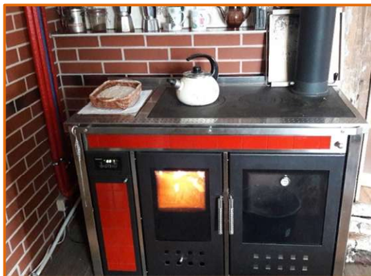
Przykład zabudowy termokuchni w miejscu starego pieca kuchennego na węgiel.
